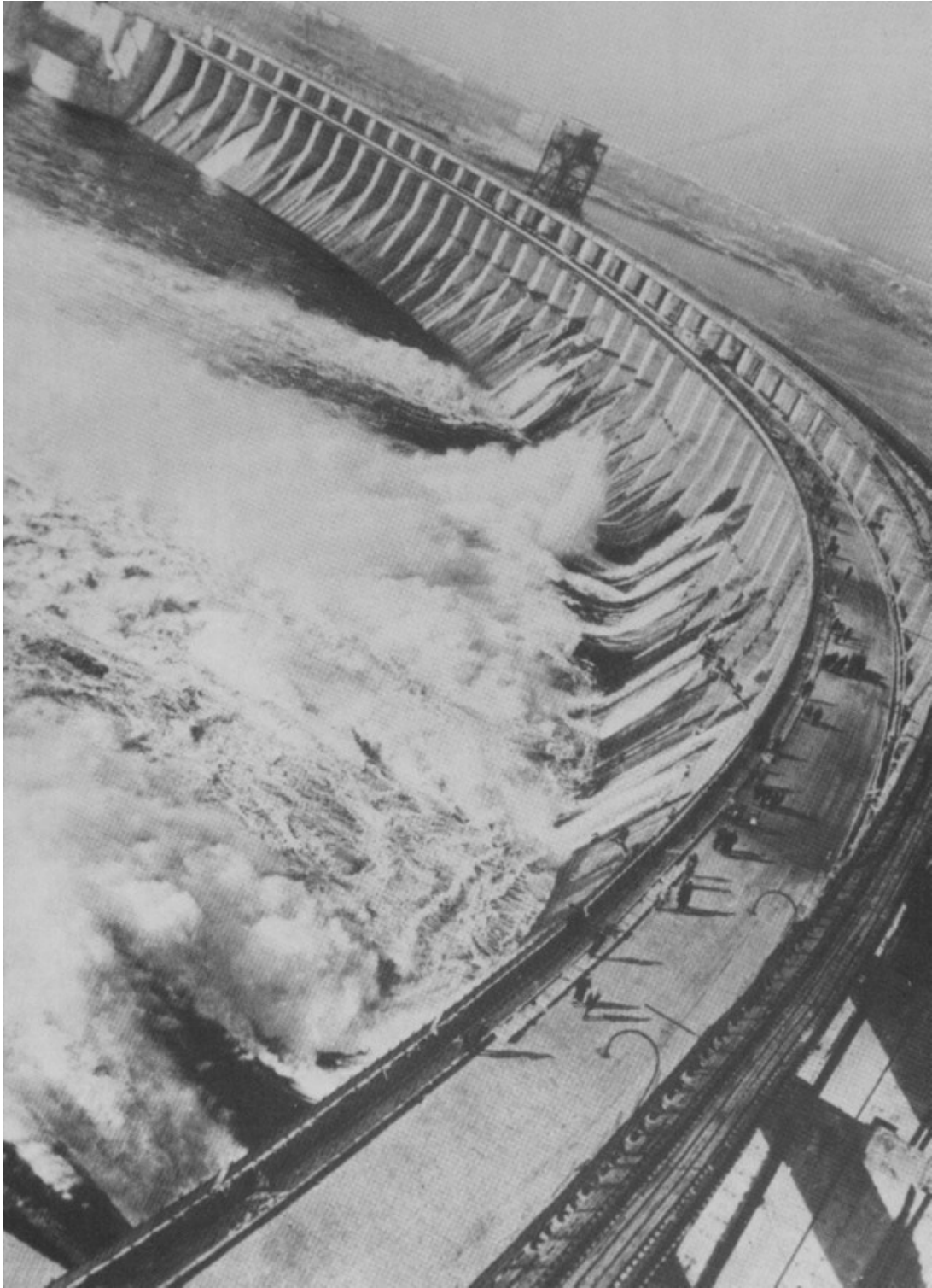
Der Bau eines Elektrizitätswerkes am Dnepr, eine der größten Errungenschaften des 1. Fünfjahrplans. Als das Elektrizitätskraftwerk 1932 fertig gestellt wurde, war es das größte der Welt.
